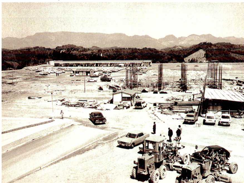
校舎建築着工 (1975)
